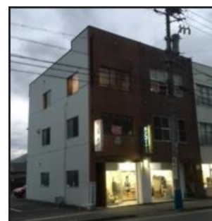
第二教室 訓練施設外観
